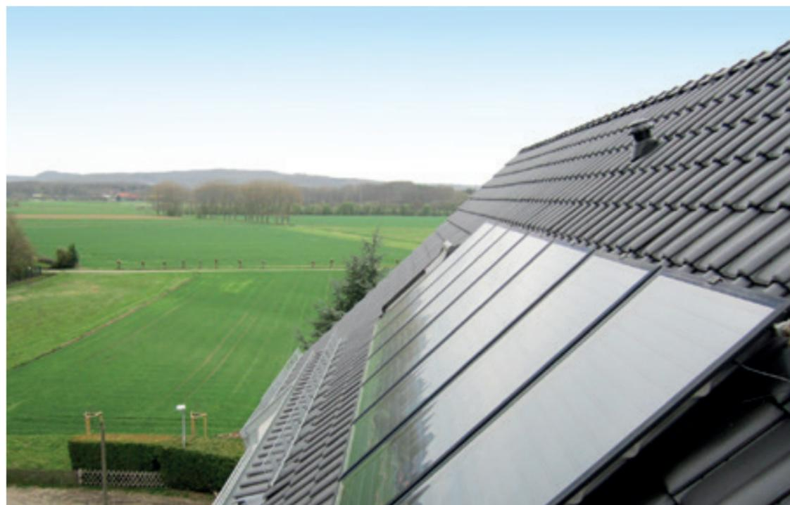
Neben dem Gas-Brennwertkessel wird zur Senkung des Primärenergiebedarfes eine Solar-Kollektoranlage mit einer Fläche von 14 m<sup>2</sup> zur Trinkwassererwärmung und Heizungsunterstützung betrieben.
