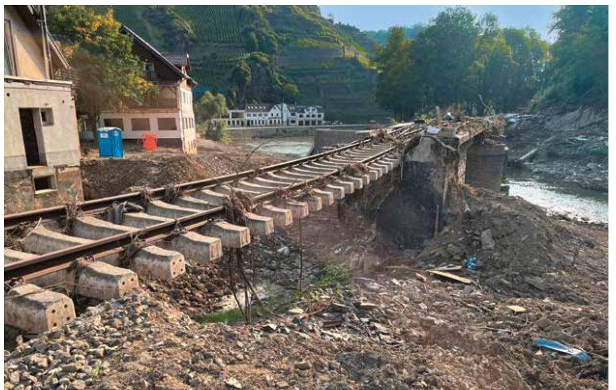
Ahrtalbahn: Unterspülte Gleise soweit das Auge reicht
