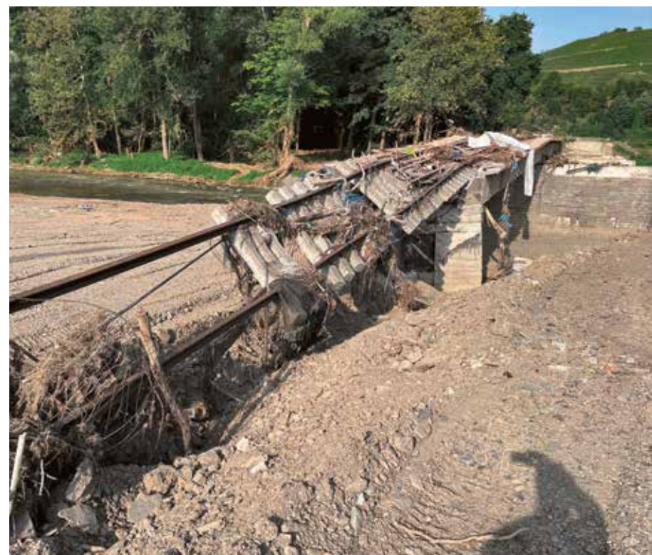
Ahrtalbahn: Unterspülte Gleise soweit das Auge reicht
