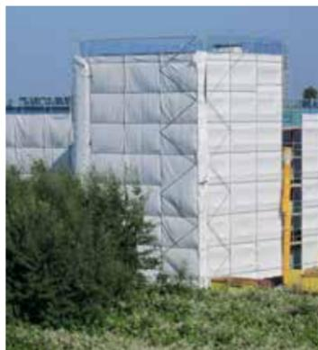
mit definierten Schwarzbereichen durchgeführt, sämtliche Asbestprodukte ausgebaut und fachgerecht entsorgt. Die Arbeiten wurden fachgutachterlich begleitet und abgenommen.
