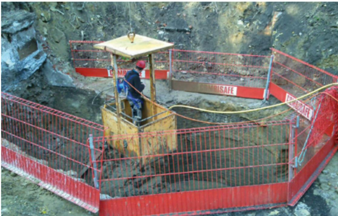
Sämtliche Arbeiten im Schachtinneren erfolgten aus dem Fahrkorb
