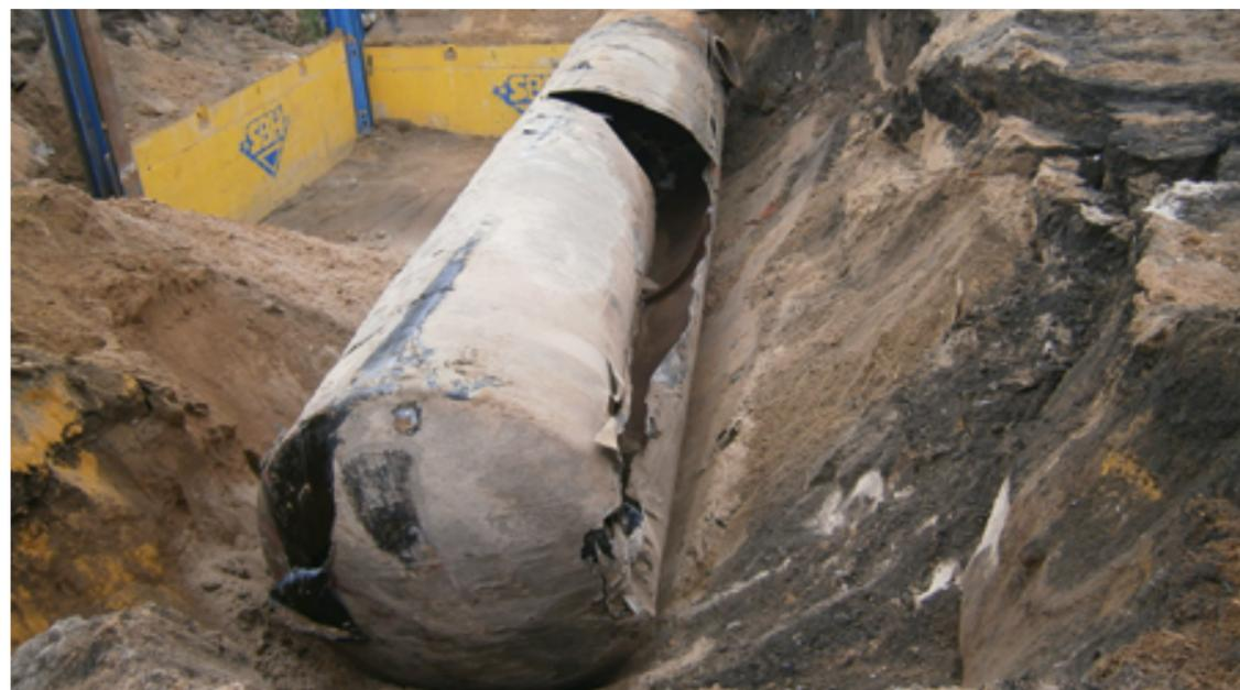
Die in 7,5 m Tiefe liegenden Tanks wurden im Schutz eines Gleitschienenverbaus zersägt
